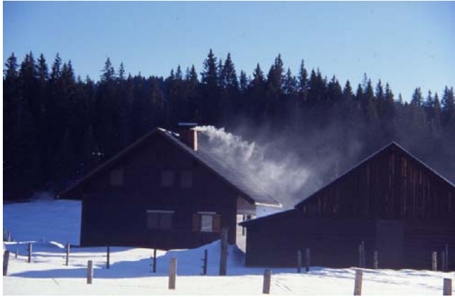
Abbildung 2.8.1.3: Infolge eines zu niedrigen Schornsteins wird die Abgasfahne an der windabgewandten Seite des Gebäudes nach unten gedrückt.
