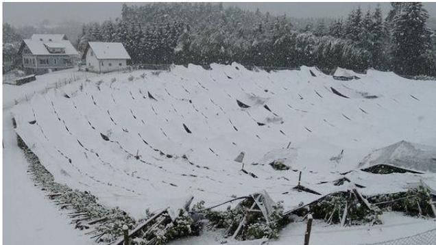
Abb. 1: Einsturz der Hagelnetze durch die Schneelast. Quelle: LWK Steiermark
