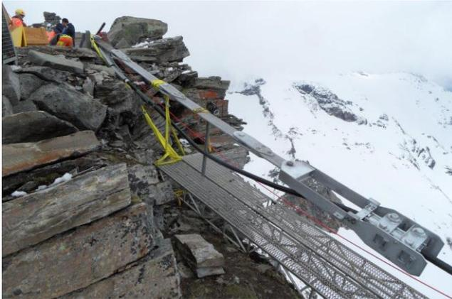
Die unter Zug stehende Schadstelle wurde mit einer Spannvorrichtung entlastet und mit einer Muffe provisorisch repariert – bis zu sieben Mann waren gleichzeitig vor Ort – unter der Spannvorrichtung befindet sich sehr viel Luft
