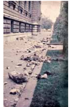
Erdbebenschaden bei der Universität in Wien, 1972
