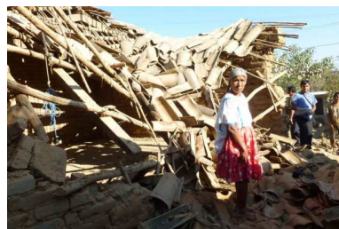
Schäden des Erdbebens am 20. März 2012 in Mexiko (Magnitude 7.4). Bildquelle: http://bit.ly/GN3opG
