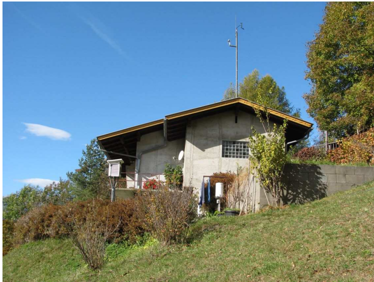
Abbildung 2.4: Windmessung am Dach eines Hauses in Obervellach
