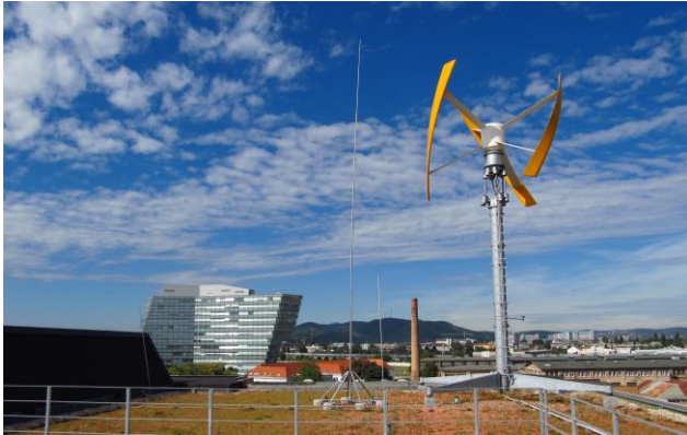
Kleinwindenergieanlage am Gebäude der ENERGYbase Quelle: Erwin Polreich
