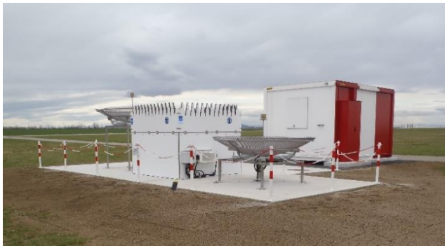
Sodar-Rass Anlage der Austrocontrol am Flughafen Schwechat Quelle: Austrocontrol
