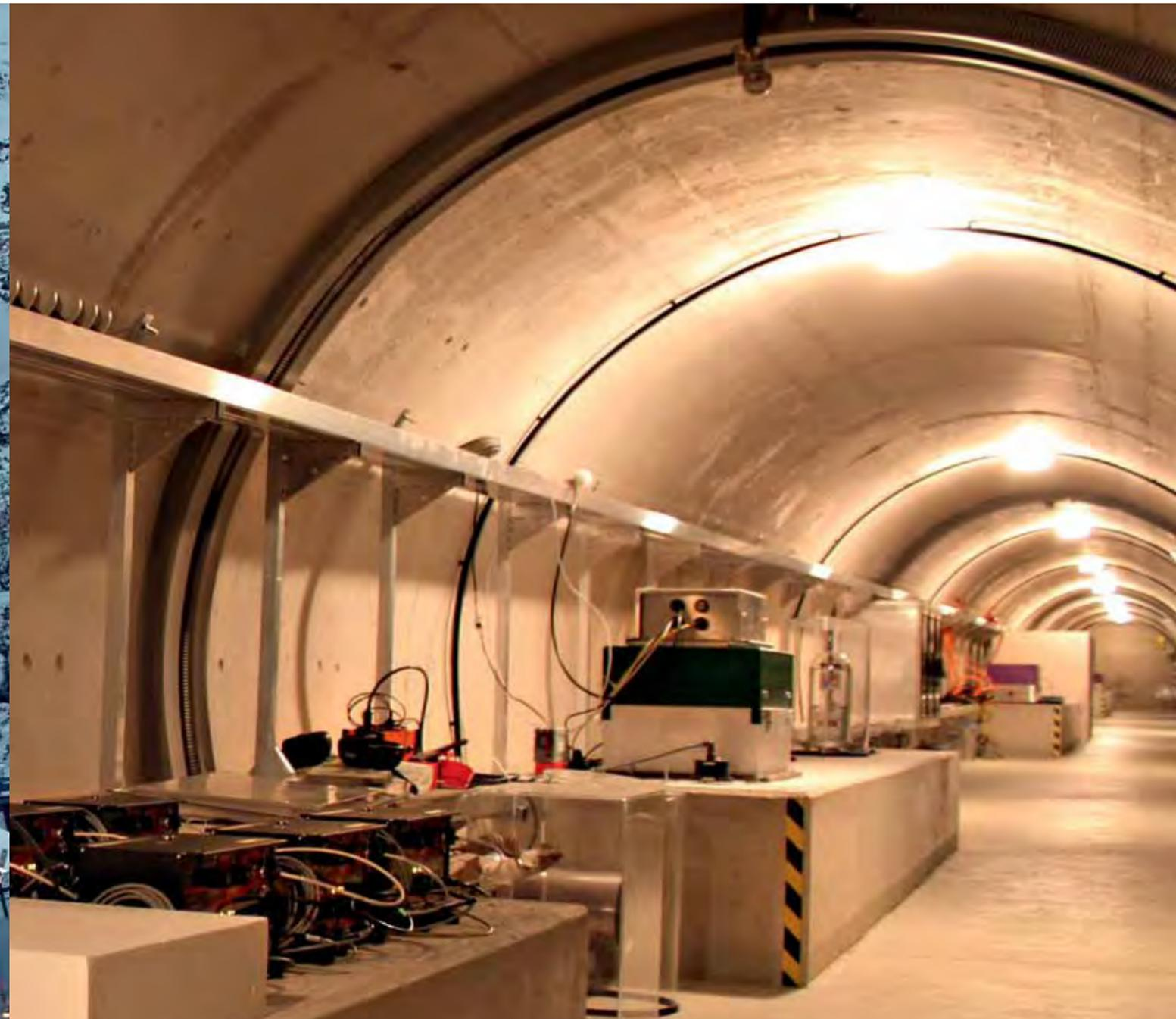
**Conrad-Observatorium** am Trafelberg (NÖ) +++ fast zur Gänze unterirdisch mit zwei Kilometer Stollen und Schächten +++ Messung und Erforschung von Erdbeben, Erdschwere, Erdmasse, Magnetfeld, geodätischen Parametern, atmosphärischen Wellen und meteorologischen Daten +++ seismisch-gravimetrischer Teil seit 2002 in Betrieb, 2013 Eröffnung geomagnetischer Teil
