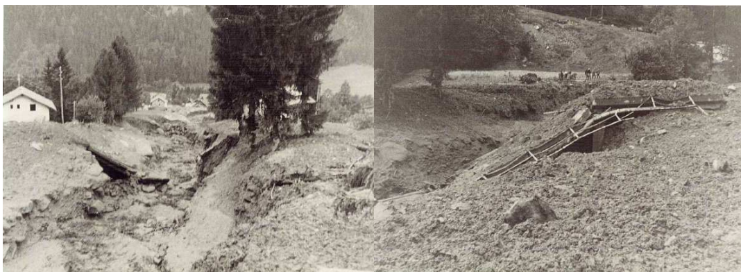
Zerstörungen durch den Wollinitzbach (Fotoquelle: Gemeindechronik Flattach).
